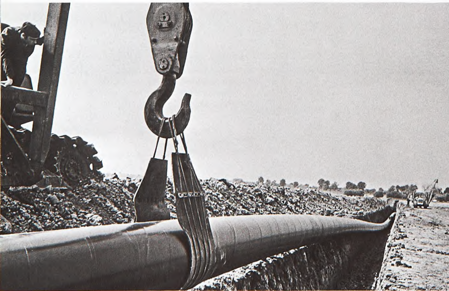
Прокладка нефтепровода в Венгрии близ Ленинвароша
