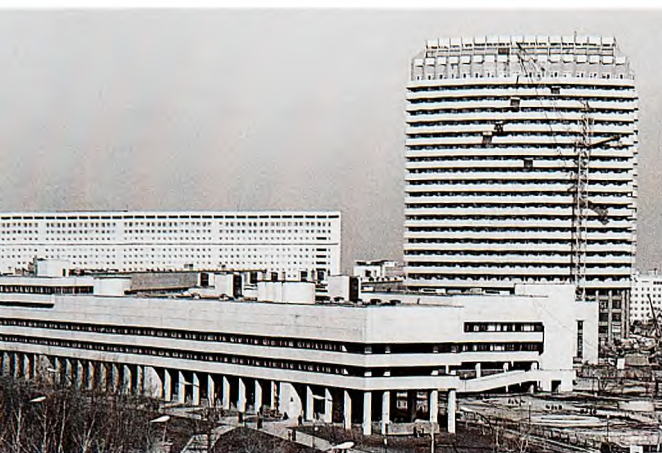
Завершение строительства онкоцентра на Каширском шоссе в Москве
